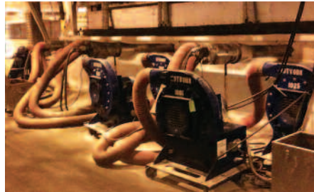
Derecha, izquierda y arriba: Drenaje y calentamiento de horno para vidrio
